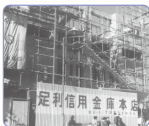
昭和 45 年 12 月 現在も本店として残っている旧足利信用金庫本店建築の様子
